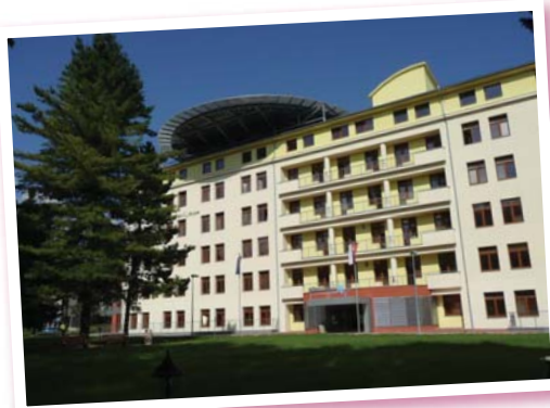
Budova Stredoslovenského ústavu srdcových a cievnych chorôb, a. s., v Banskej Bystrici po rekonštrukcii
